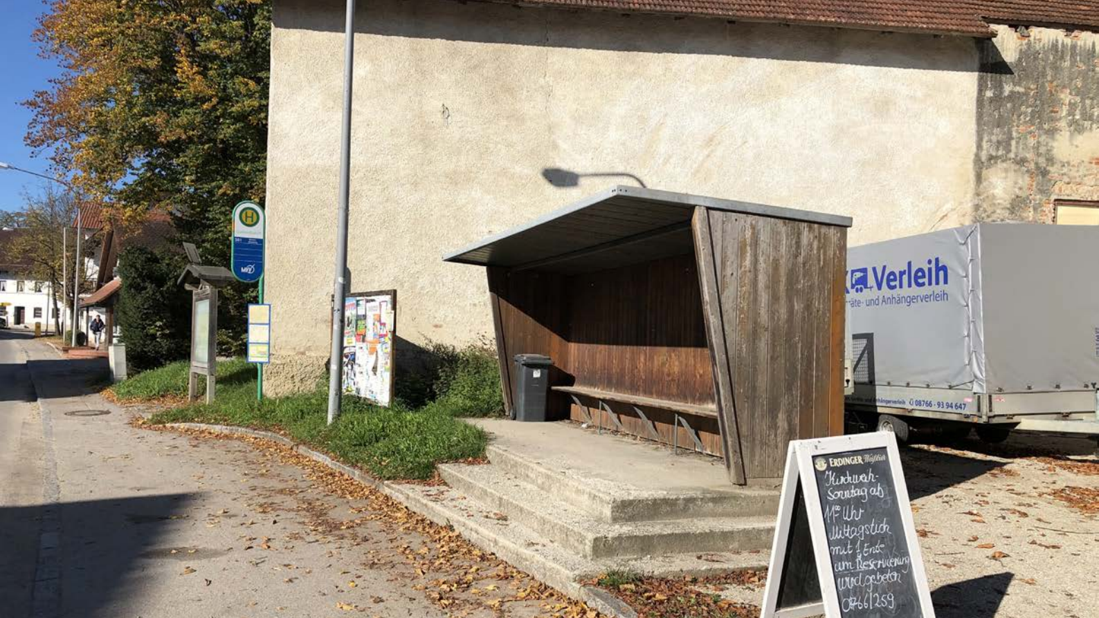
Nicht barrierefrei gestaltete Bushaltestelle
