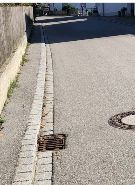
Gehstreifen entlang der Hauptstraße
