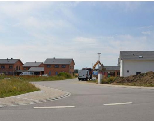
Neues Baugebiet am Holledauer Ring
