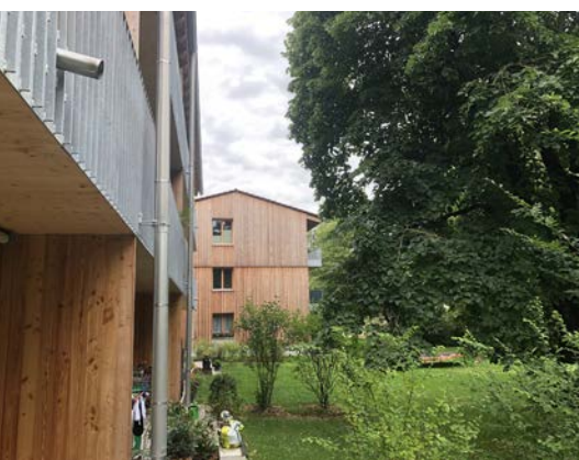
Kranzberg - Kommunalen Wohnungsbau
